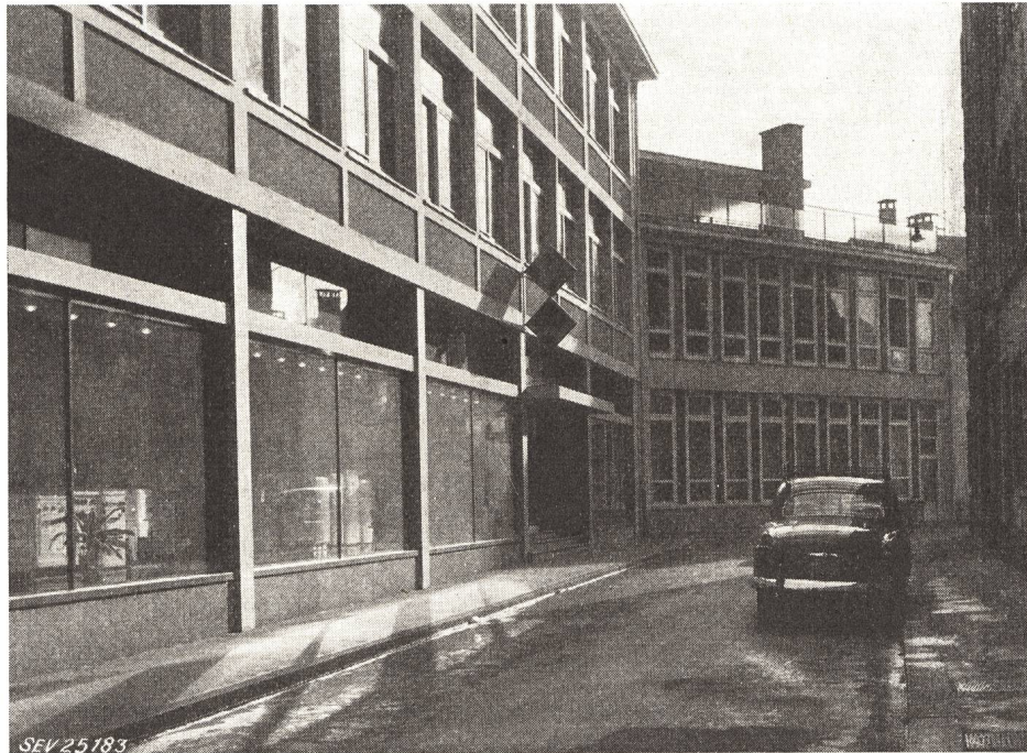
Fig. 11 Saaleingang an der Kohlenberggasse mit den beiden Stockwerken für die Schulen
