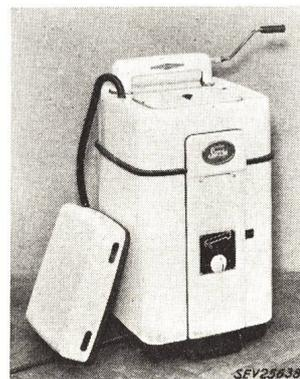
und Zentrifugalschalter. Schalter für Heizung und Motor, sowie Motorschutzschalter eingebaut. Temperatursicherung im
