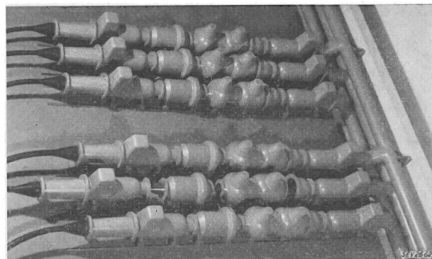
Fig. 1 Modell einer Hochspannungs-Fugenanlage Zwei Feeder, Reihe 110 kV
