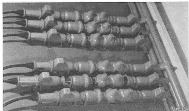
Fig. 1 Modell einer Hochspannungs-Fugenanlage Zwei Feeder, Reihe 110 kV
