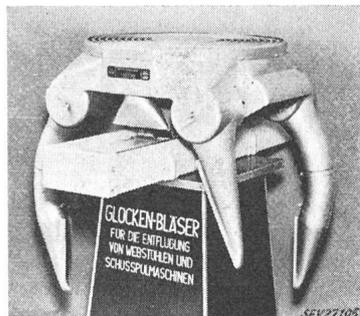
und Stromabnehmern versehen ist. Ein gekapselter Drehstrom-Kurzschlussankeromotor treibt das Gebläse und, über ein Getriebe, auch die Laufrollen an. Eine Laufschiene ist blank und durch Stromabnehmer mit dem Motoreisen verbunden.
