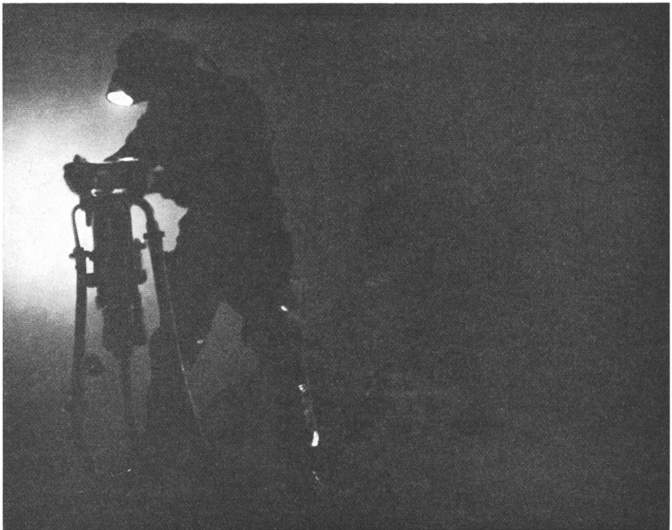
Fig. 7 Arbeit im Stollen
