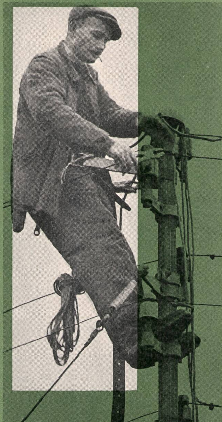
Freileitungsmonteur an der Arbeit auf einem Dachständer
