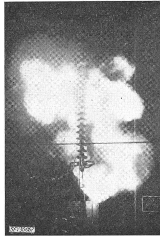
Fig. 3 4000-A-Lichtbogen über eine 220-kV-Isolatorenkette 0,43 s nach der Zündung
