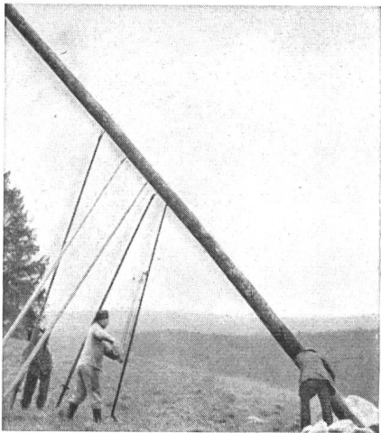
Leitungsbau im Kanton Bern mit LIFTY Stangenwinde
