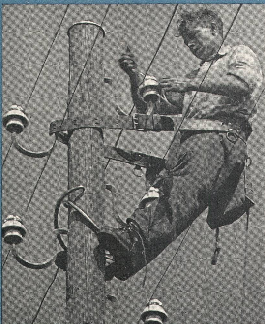
3 Arbeit an einer 16 kV-Leitung
