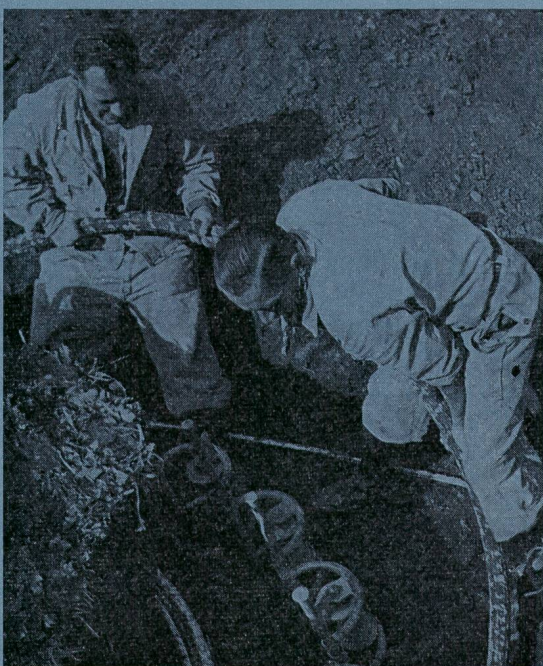
③ Nachzug eines Verteilkabels
