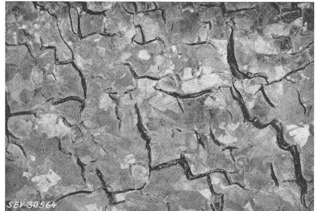
Fig. 4 Bleimantel-Zersetzung an einem 12-kV-Kabel 3 \times 185 \text{ mm}^2 (vergrössert)
