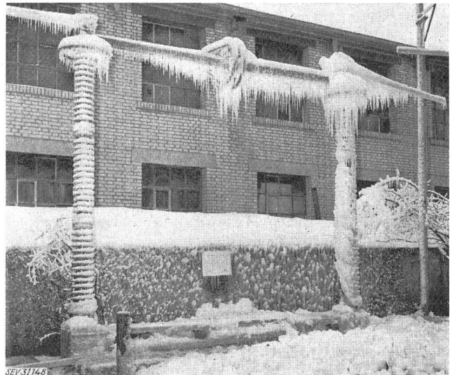
Fig. 8 Vereisungsversuch an einem 2-Säulen-Trenner 420 kV
