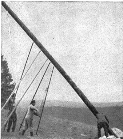
Leitungsbau im Kanton Bern mit LIFTY Stangenwinde
