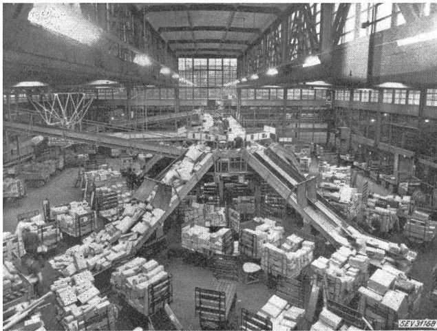
Fig. 10 Gesamtansicht einer Paketsortieranlage
