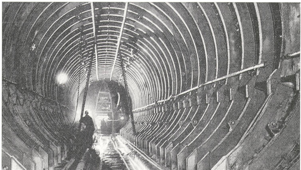
Fig. 21 Druckstollen Sufers—Bärenburg der Kraftwerke Hinterrhein
