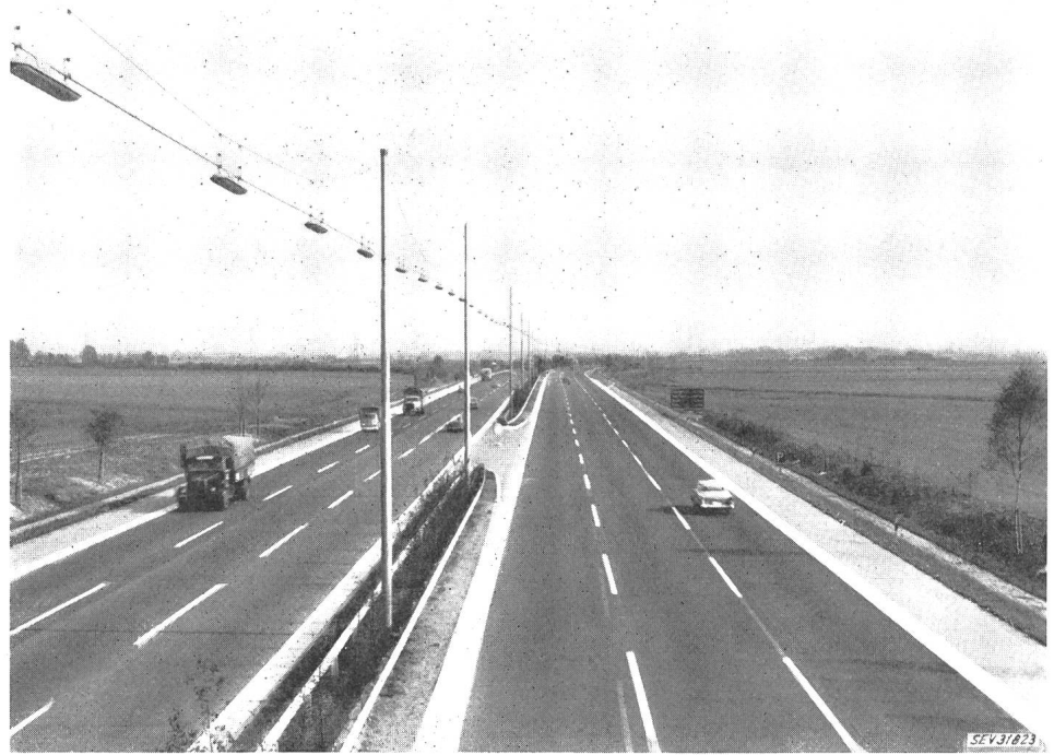
Fig. 1 Autobahn Köln-Leverkusen (6+2spurig), Versuchsstrecke mit Längs- kette über dem Mittelstreifen
