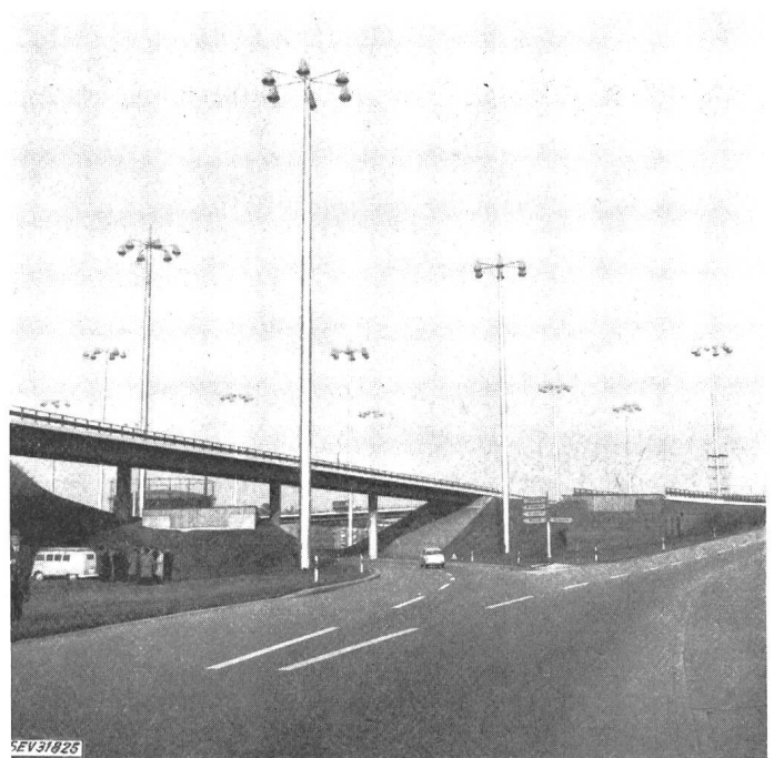
Fig. 3 Beleuchtungsanlage des Heerdter-Verkehrs-Dreiecks in Düsseldorf mit Hochmasten
