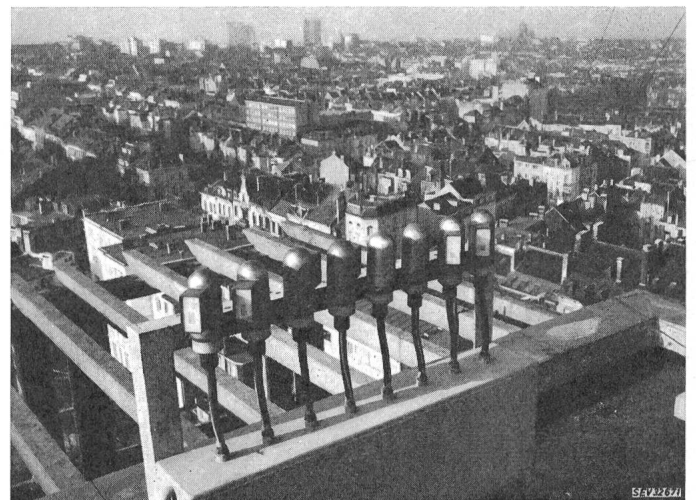
Fig. 14 Cellules photo-électriques commandant l'éclairage des tunnels des boulevards de Bruxelles (Belgique)
