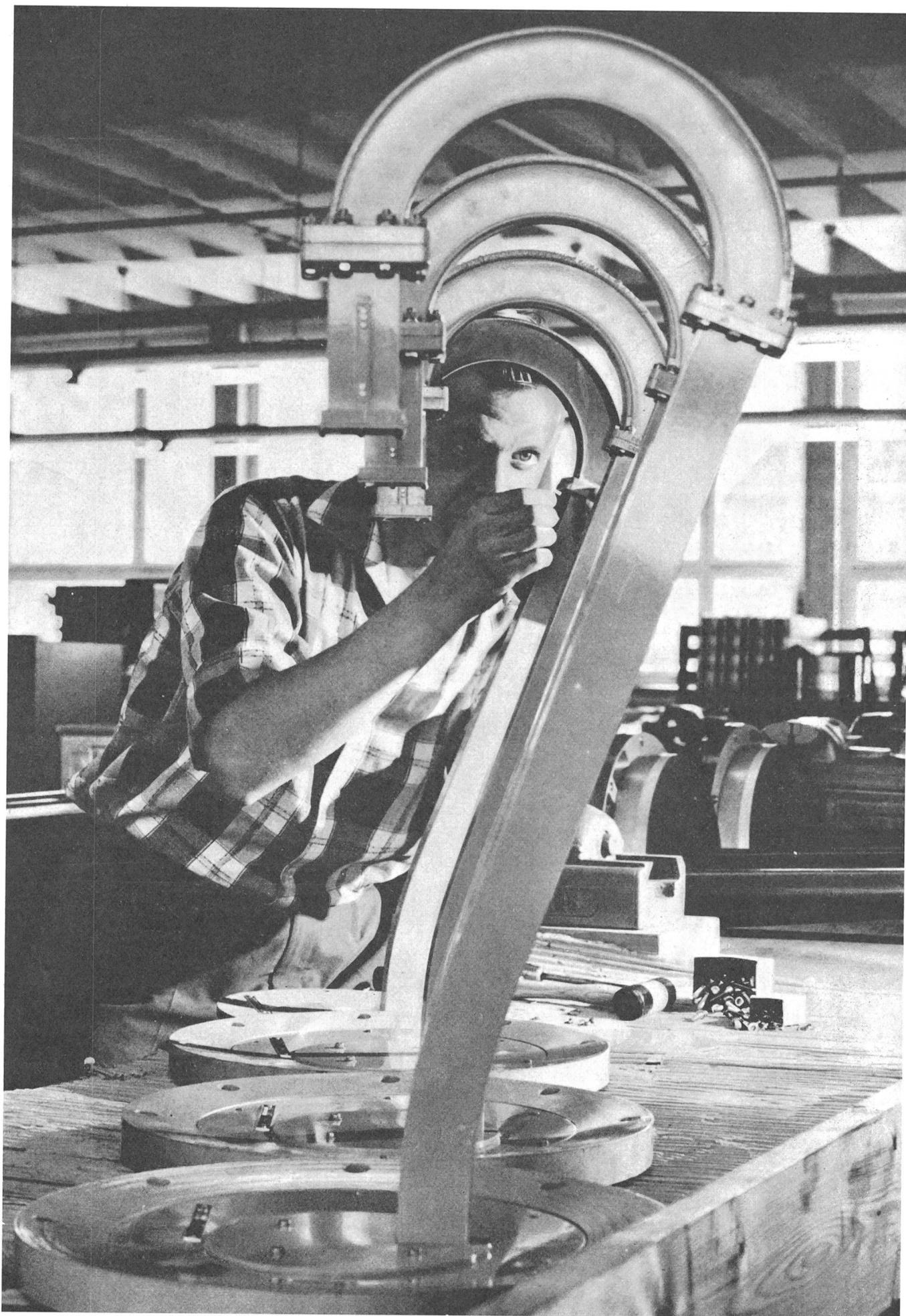
Montage eines 4-GHz-Hohlleiters in einer Werkstatt von Telefunken
