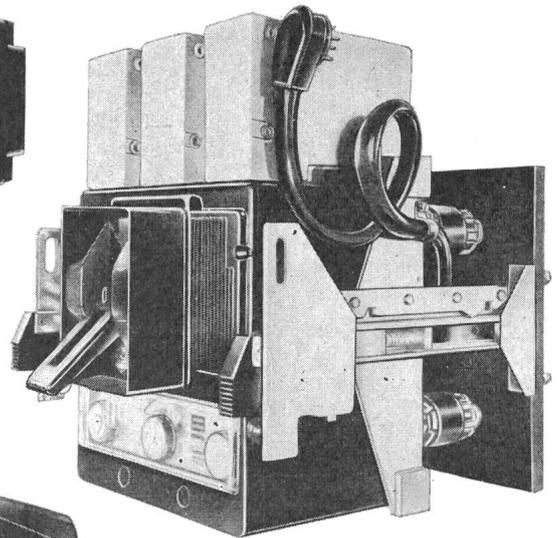
Die garantierten Abschaltvermögen gelten auch bei verzögerter Auslösung bis 0,4 Sek., was bei Selektivschaltung eine zusätzliche Sicherheit bedeutet.
