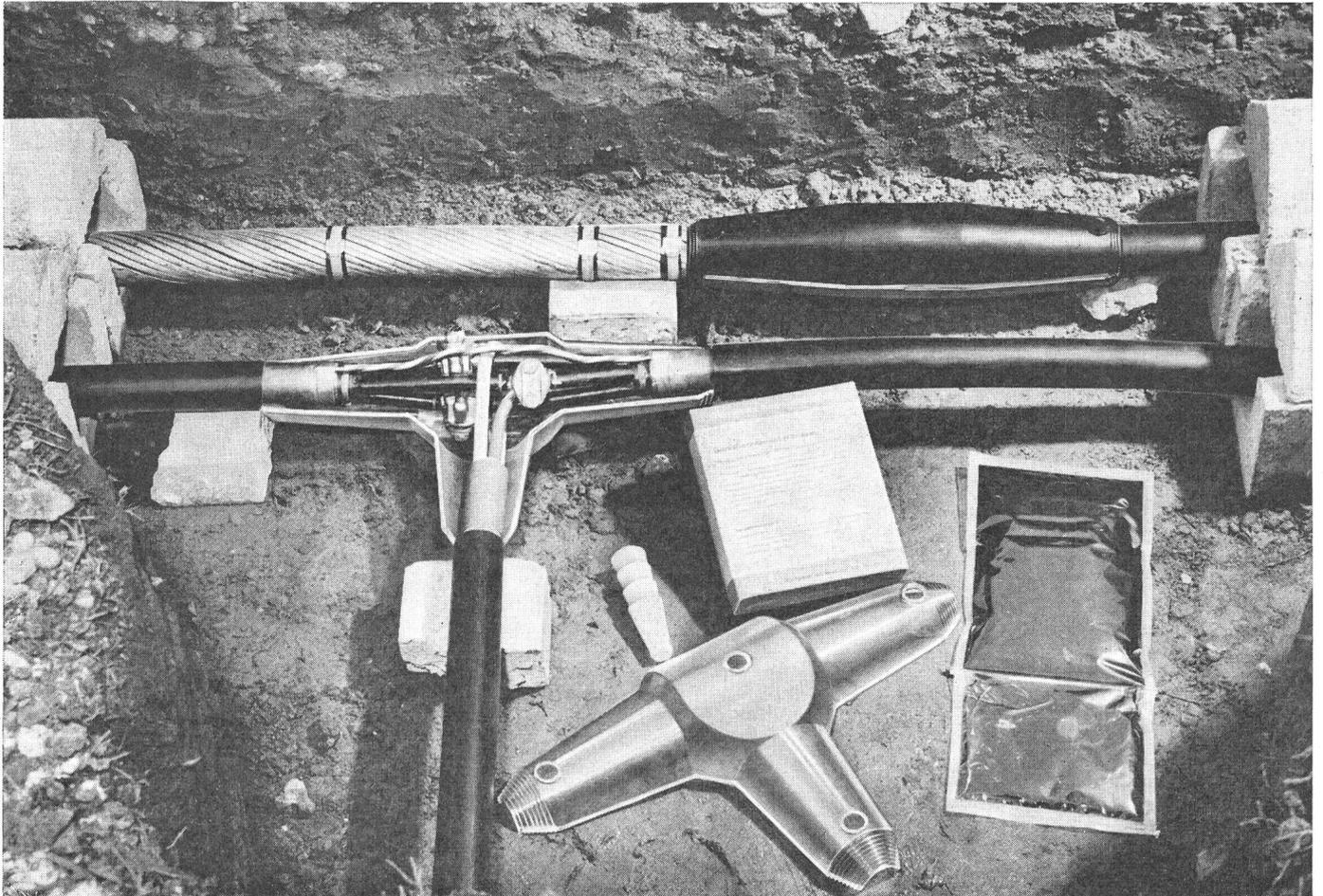
Giessharz-Kabelarmaturen zur Verbindung aller Kabeltypen:
