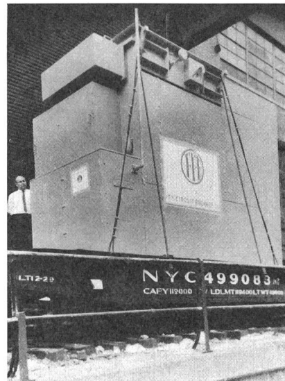
Fig. 16 ITE-Rectiformer für 75 kA bei 30 V
