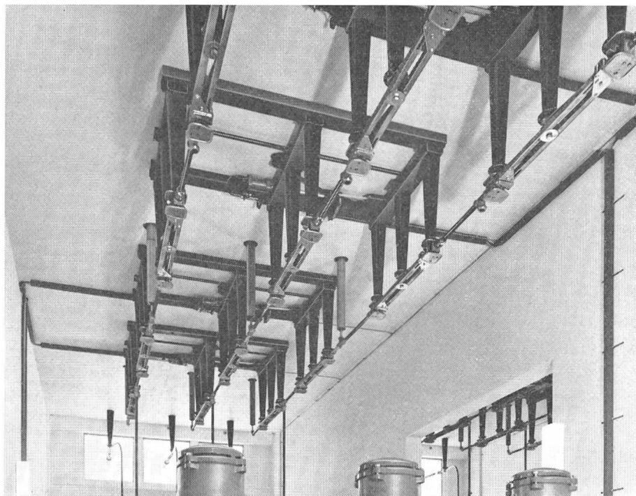
Depuis plusieurs années, GARDY construit des sectionneurs rotatifs de 52 et 72,5 kV ; 800 et 1600 A, dont l'un des principaux avantages est un gain de place considérable dans les installations.
