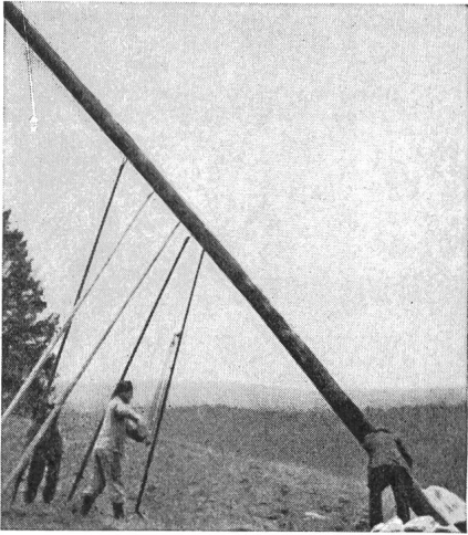
Leitungsbau im Kanton Bern mit LIFTY Stangenwinde
