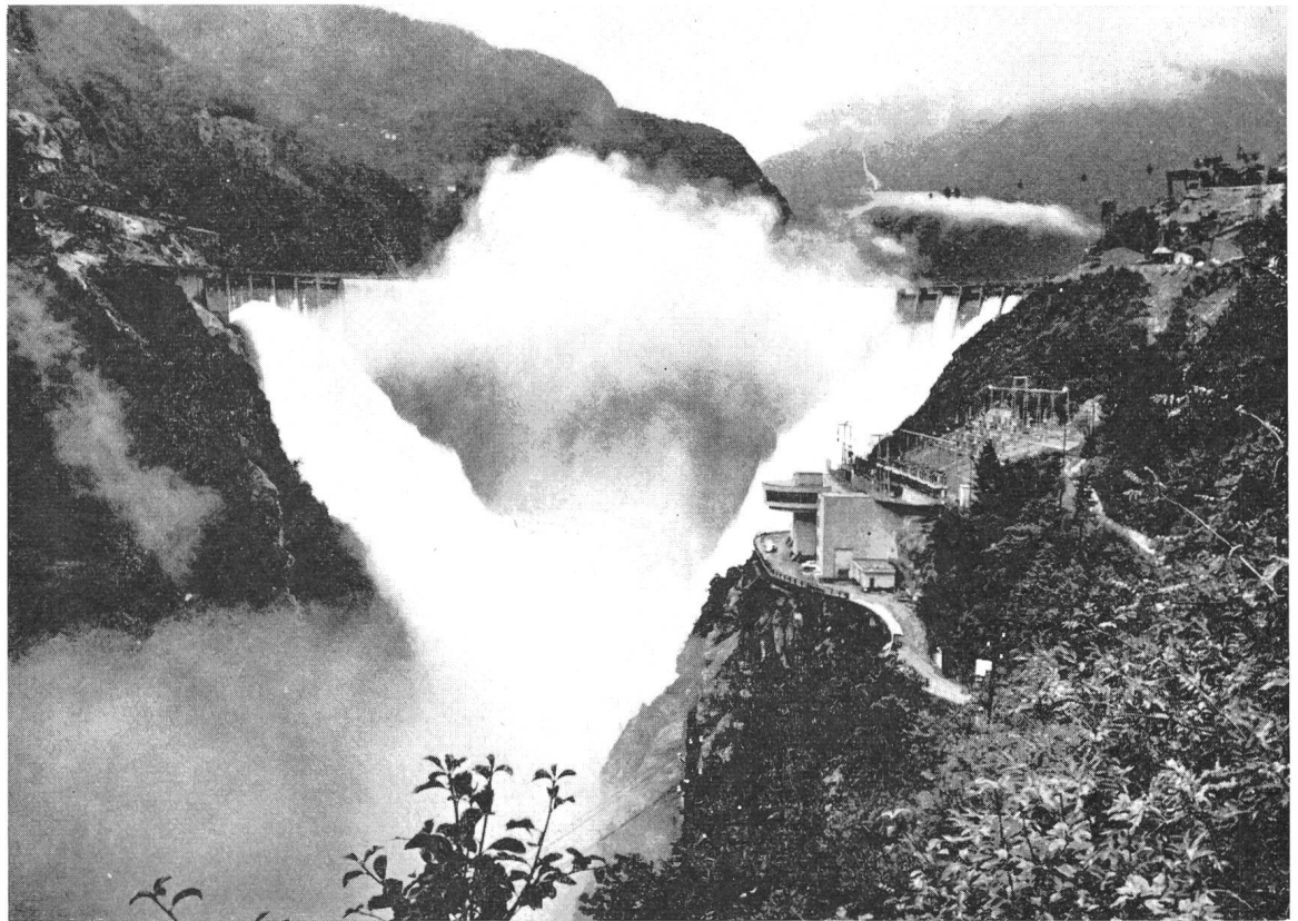
Fig. 4 Staumauer mit beidseitig geöffneten Überläufen Rechts das Kommando- gebäude mit der Freiluftanlage
