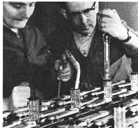
Fig. 1 Einfache Kontrolle und Wartung stationärer Batterien dank der Electrona-Einfüllpfropfen
