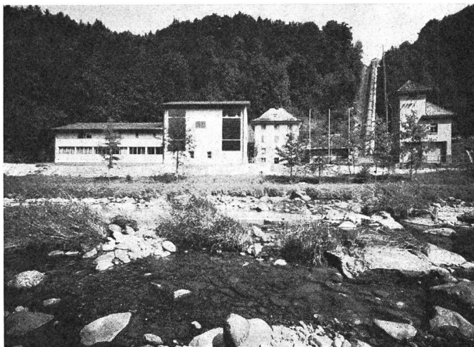
Fig. 2 Maschinenhaus, Wohnhaus, Druckleitung und Schaltstation Haslaub
