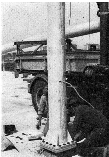
Fig. 4 Fixation d'un mât sur le viaduc
