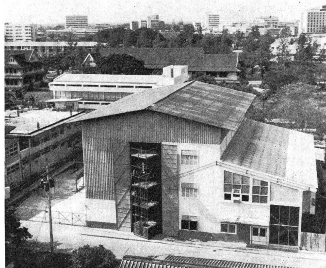
Fig. 6 Ansicht des Laboratoriums von Norden
