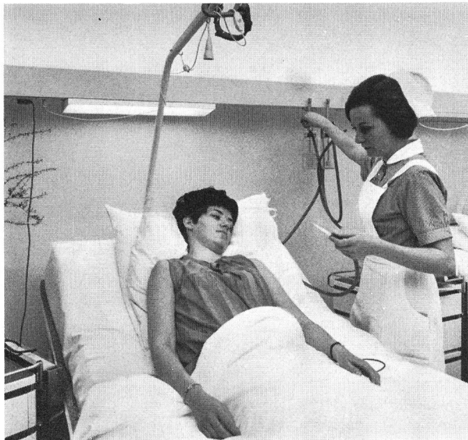
Stationäre Entnahme bis zu vier medizinischer Gase.
