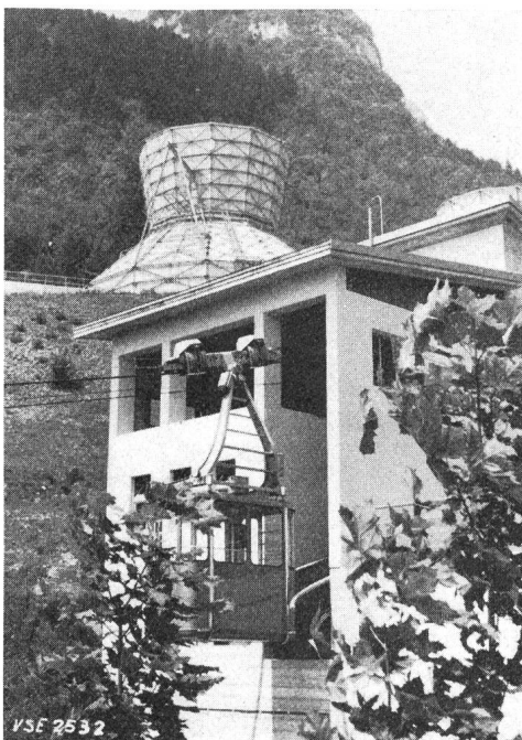
Fig. 9 Personalseilbahn, darüber einer der vier Kühltürme
