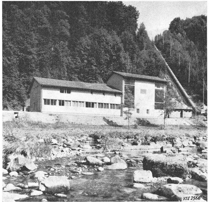
Fig. 2b Das neue Maschinenhaus Aufnahme 1967
