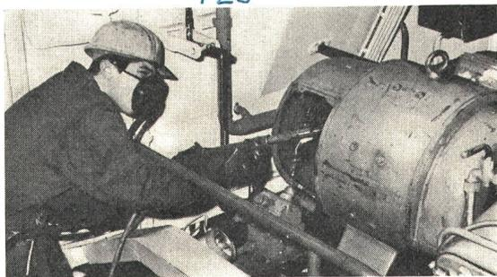
gerät zu verwenden, da die Dampfkonzentrationen in derart engen und schlechtbelüfteten Räumen sehr rasch extrem hohe Werte annehmen können. (Burson-Marsteller Int'L, Genf)
