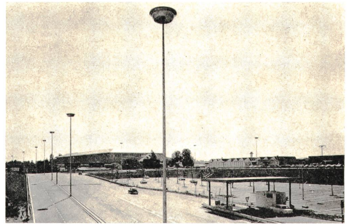
Fig. 6 Autoroute et entrée Parking. Coffret de distribution
