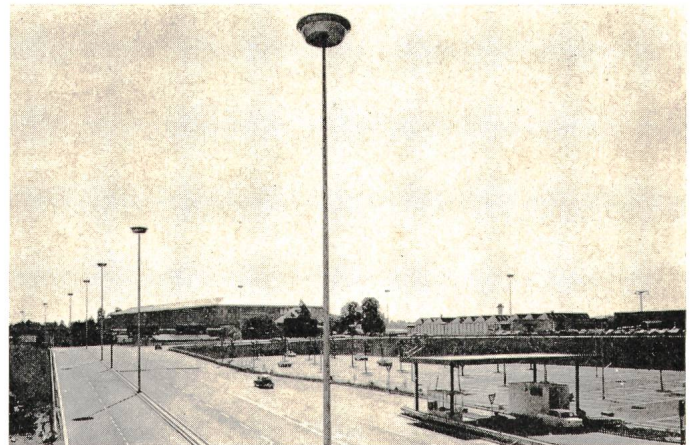
Fig. 6 Autoroute et entrée Parking. Coffret de distribution
