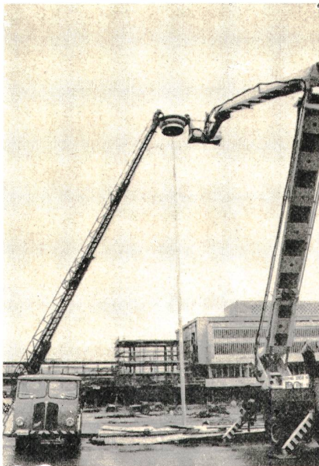
Fig. 5 Montage et réglage d'un luminaire
