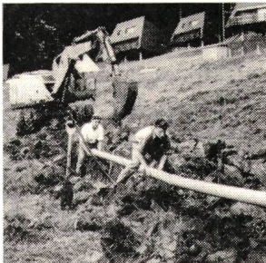
Kanalisation Schwyz: Rothenturm
