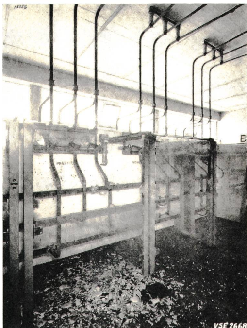
Fig. 2 Wirkung eines Kurzschlusses ohne Sammelschienenschutz
