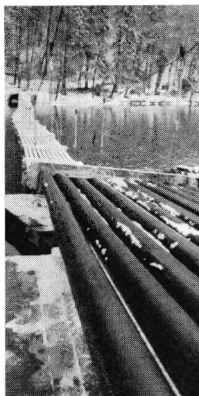
Verlegung von Kabel- schutzrohren in die Arve/Genf
