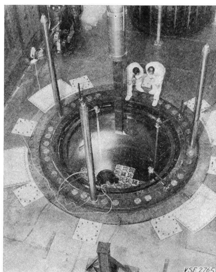
Fig. 3 Einsetzen der Brennelemente im Atomkraftwerk Beznau
