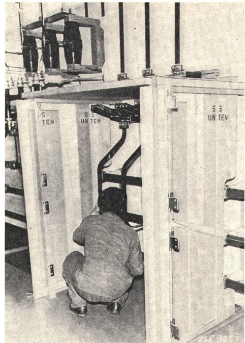
Fig. 6 Arbeit in einem mit mobilen Schutzwänden abgetrennten 16-kV-Feld
