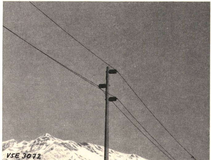
Fig. 1 50-kV-Leitung Biasca-Aquarossa der AET, Baujahr 1950
