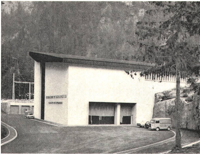
Aussenansicht des Maschinenhauses
