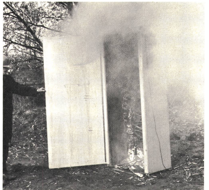
Nach Öffnen des Schaltschranks Entflammung der Kunststoffisolation infolge Sauerstoffzufuhr. Lösversuche mit Halon, CO 2 und ABC-Staub Ouverture de la porte de l'armoire. Allumage de l'isolation synthétique par l'accès d'oxygène. Essai d'extinction avec Halogène, poudre ABC et CO 2
