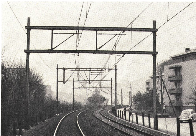
Fig. 8 2feldrige Nachspannung (entsprechend Fig. 7)
