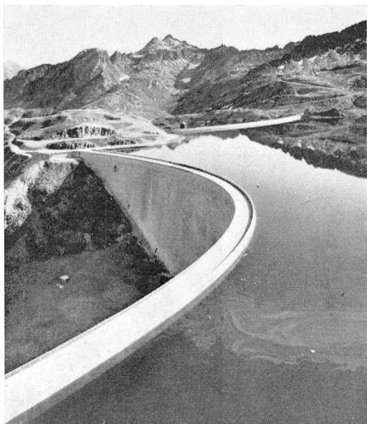
Fig. 5 Staudamm von Naret
