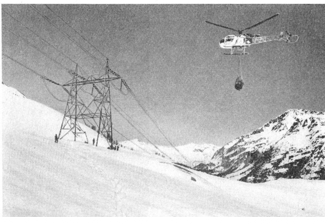
Fig. 3 Leitungsreparatur in den Alpen
