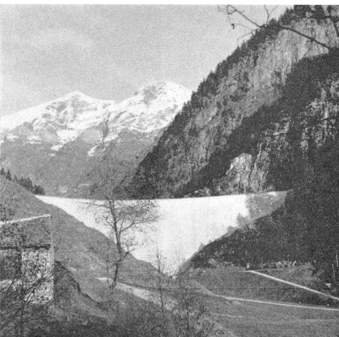
Fig. 5 Staudamm von Malvaglia
