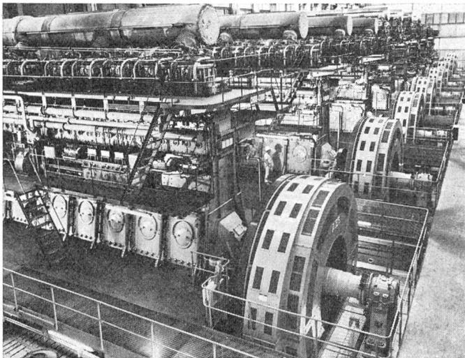
Für den Einbau der drei neuen Gruppen muss die Dieselzentrale entsprechend verlängert werden. Sie wird mit einer Gesamtleistung von 100 000 kW die grösste Dieselzentrale der Welt sein. Die Bestellung umfasst ausser den Hauptmotoren die gesamten Anlagenteile, wie Kühlwasserpumpen, Brennstoff- und Ölpumpen, Brennstoffaufbereitung, Vorratshaltung, Wasseraufbereitung, Abgaswärmeverwertung und Feuerlöschanlage.
