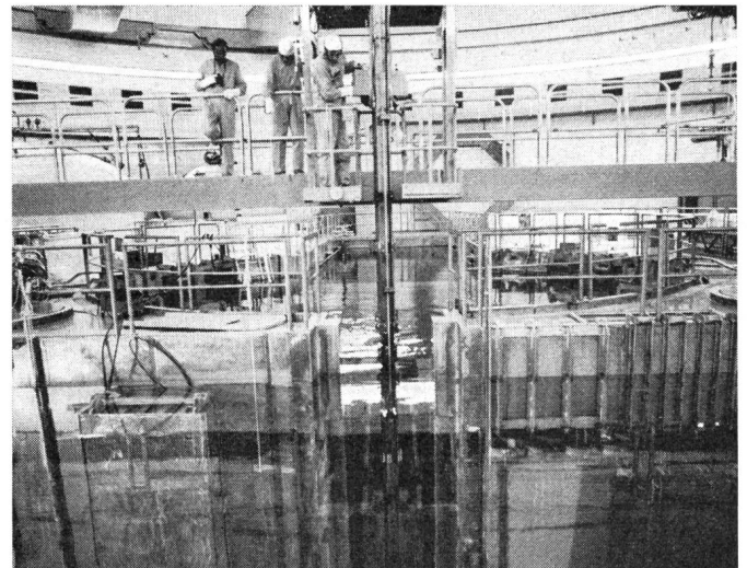
Fig. 1 Echange de combustible: plate-forme de manipulation de la machine à échanger les éléments de combustible.
