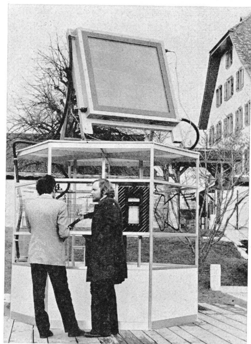
Fig. 1 Demonstrationsmodell eines Sonnenwärme-Kollektors
