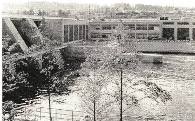
Fig. 5 Reusskraftwerk Bremgarten-Zufikon (Inbetriebnahme Herbst 1975)
