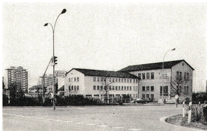
Fig. 4 Kreisbüro Rheinfelden mit angebautem Unterwerk
