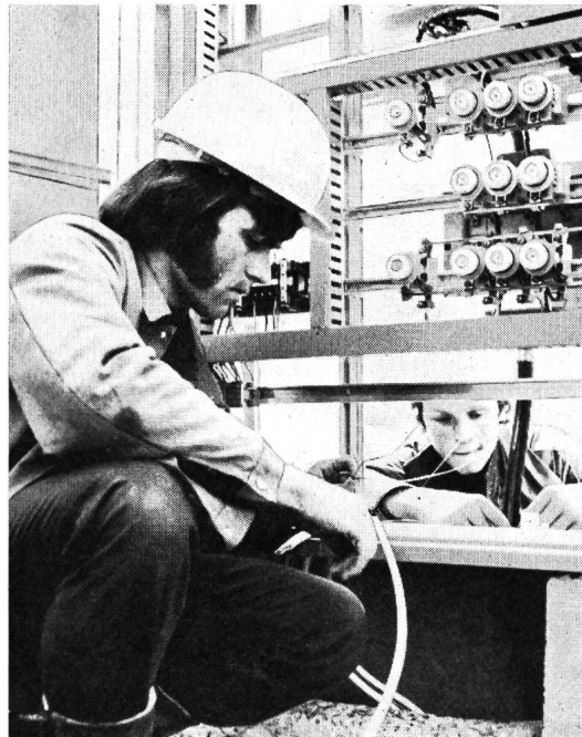
Fig. 3 Installationsmonteure beim Ausrüsten einer Hauptverteilung
