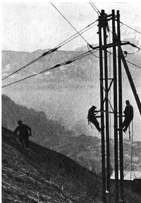
Fig. 1 Verankerung eines Abspanngestänges in steilem Gelände
