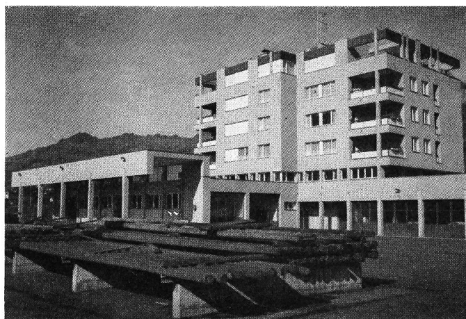
Fig. 1 Werkhof mit Wohnungen
