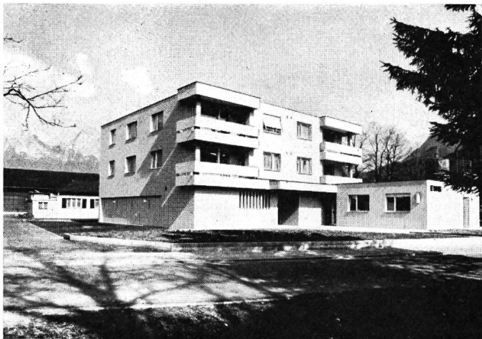
Fig. 2 Magazin- und Wohngebäude des EWS in Brunnen
