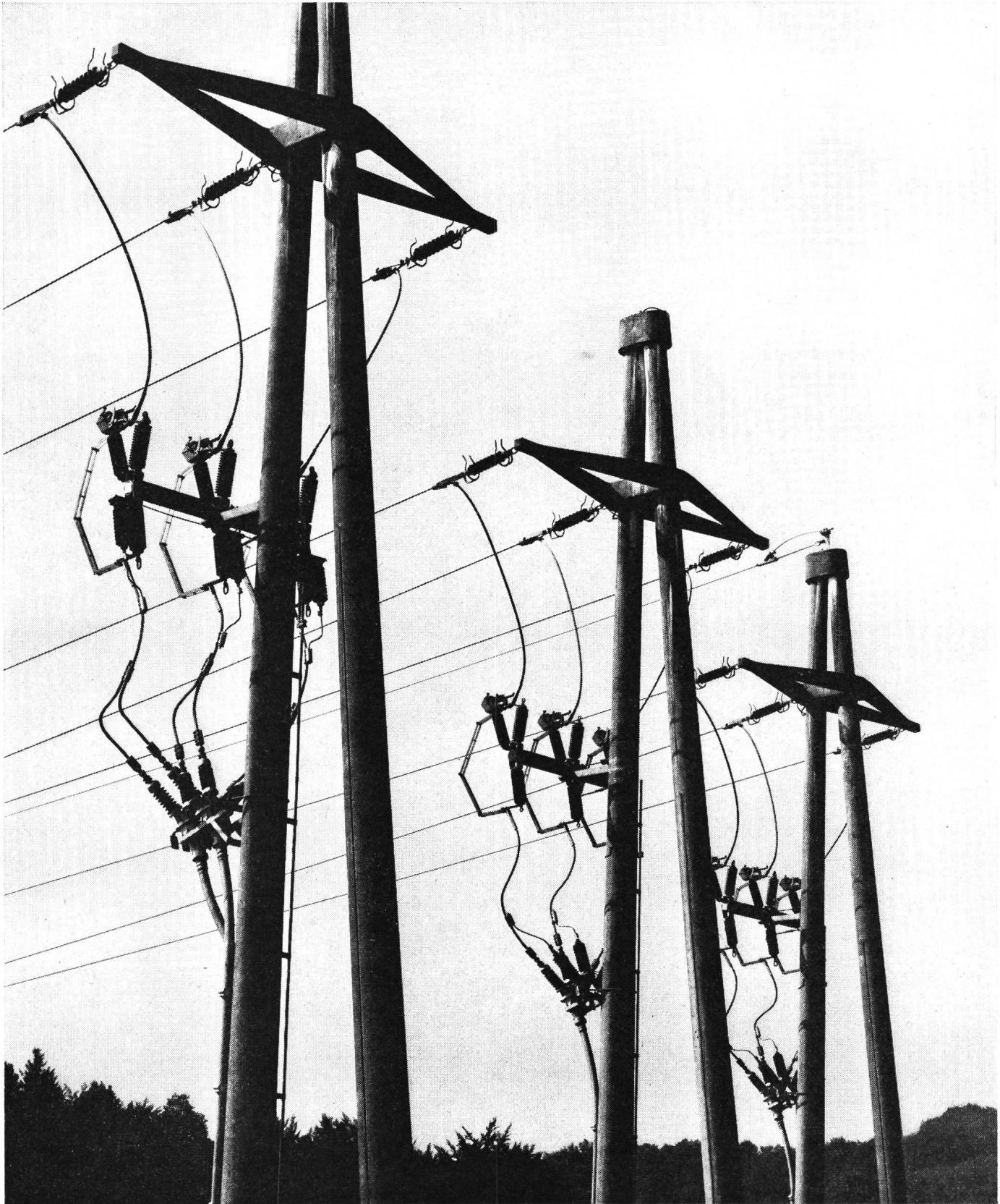
Energietransport ist ein komplexer Vorgang, vergleichbar einem Konzert: alles muss aufeinander abgestimmt sein und technisch fehlerfrei zusammenwirken. Unser Bild: Übergang von 20 kV-Dreileiter-Haftmassenkabeln auf 3 Freileitungen unter Verwendung von Dreileiter-Freiluft-Endverschlüssen auf Konsolen mit Überspannungsableitern.
