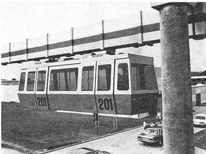
1978 vollautomatisches Fahren mit sechs Kabinen, und zwar mit zwei Kabinentypen, einer Kleinkabine für 17 und einer mittलगrossen für 40 bis 50 Insassen. In Spitzenverkehrszeiten können zwei gekoppelte Fahrzeuge dieser Art im 60- bis 80-Sekunden-Takt auf einer Linie in jeder Richtung stündlich 5000 bis 6000 Personen befördern. Für besondere Fälle, mehr als 10 000 Fahrgäste je Stunde, sind Gelenkkabinen mit über 200 Plätzen vorgesehen.
